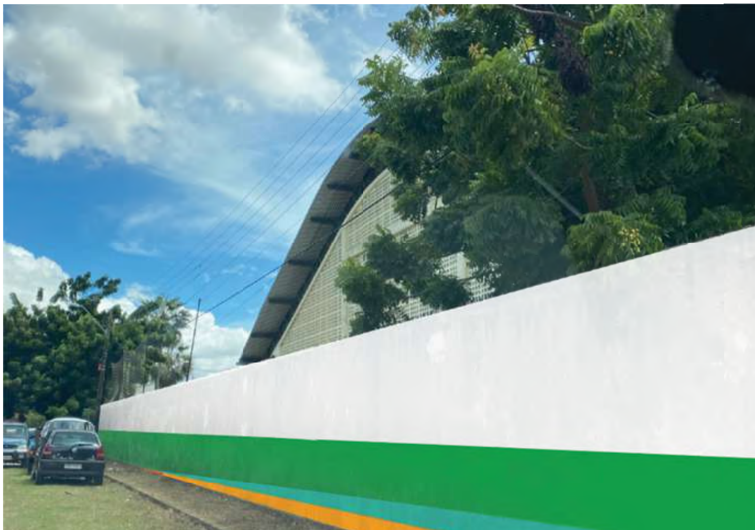
Muro Externo - Costas
